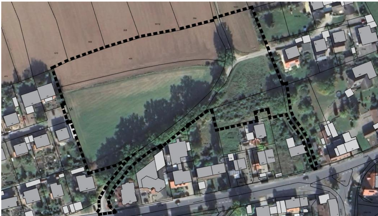
Abbildung 1: Orthofoto des Planungsgebiets mit dem Geltungsbereich des Bebauungsplans (Google earth, zugegriffen am 12.06.2023)
