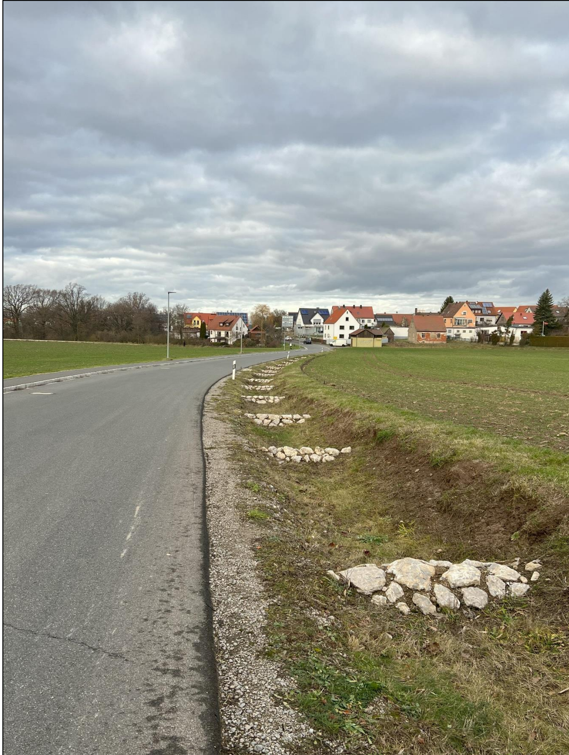
Neu angelegter Straßenbegleitgraben parallel der Buchschwabacher Straße zwischen der Sportmeile und den bebauten Siedlungsstrukturen von Roßtal © Ingenieurbüro Christofori und Partner
