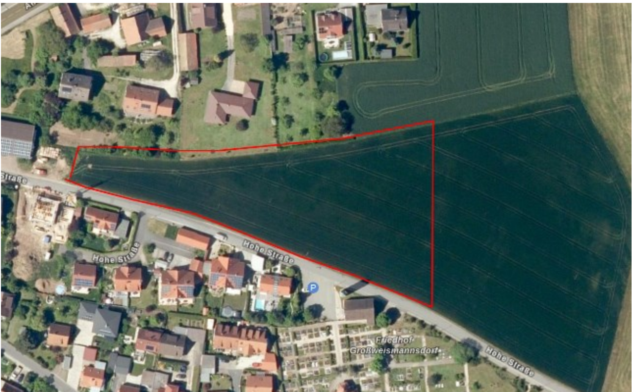
Abbildung 2: Das Vorhabensgebiet (rot umrandet) (Luftbild: Bayernatlas)
